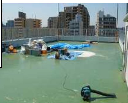
夏の1号館屋上の防水工事 新学期に備えて万全の対策
